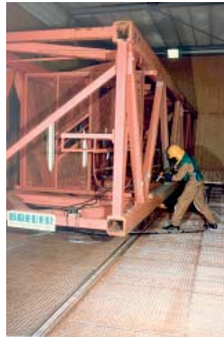
Stahlkonstruktionen Steel construction
