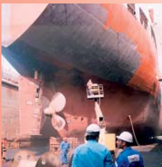
Schiffssanierung Ship renovation
