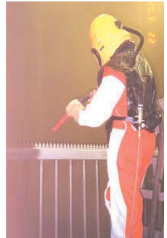
Gitterstrahlen Grid sandblasting
