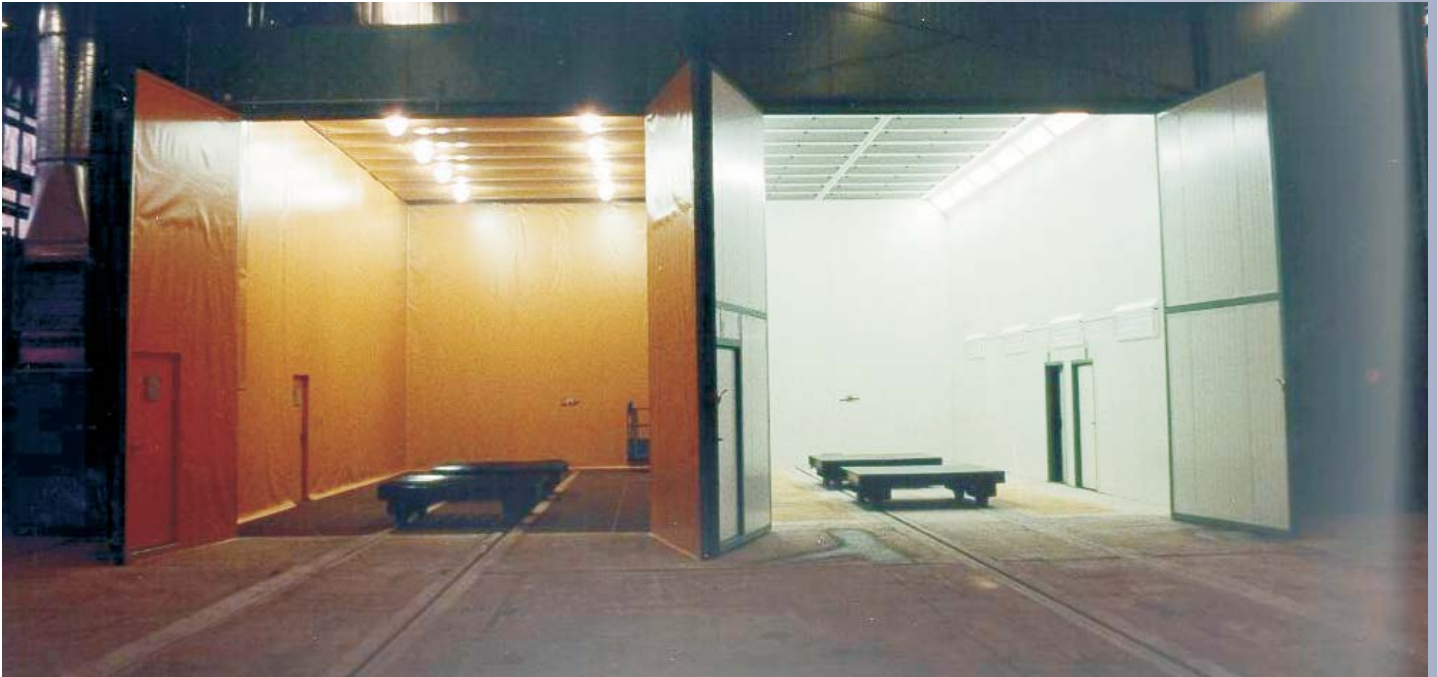
Schlüsselfertige Installation von kombinierten Strahlhallen
