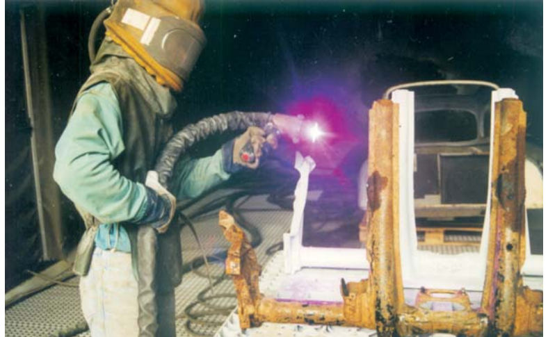
Verzinken in der Strahlhalle – ist die beste Art Korrosion vorzubeugen
